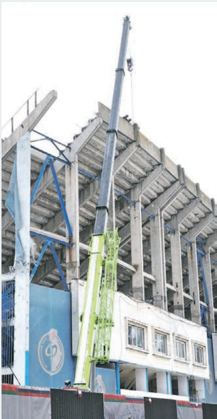
Верхний ярус Центральной трибуны на улице Студенческой разбирают с помощью подъёмного крана
