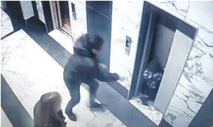
Неисправная дверь лифта едва не привела к трагедии
