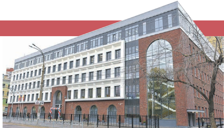
Школа № 45 получила не только современный вид, но и передовое оборудование
