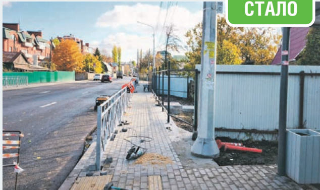
Работы по обустройству тротуара почти завершены
