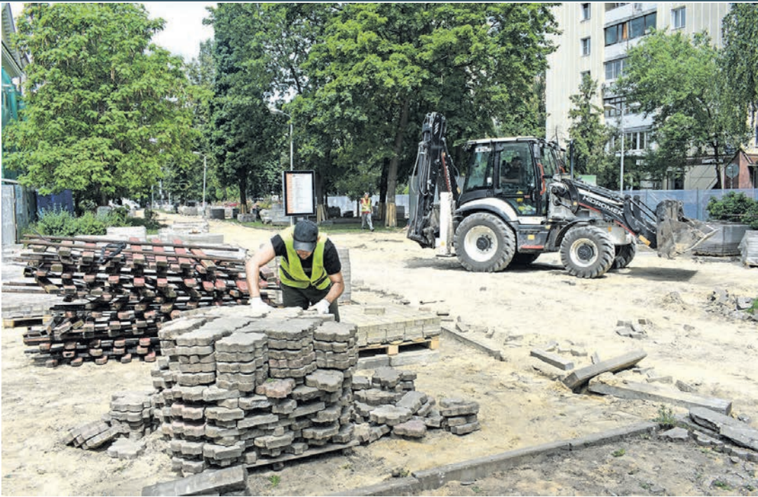
Согласно документам, работы на участке улицы Карла Маркса должны завершить до ноября
