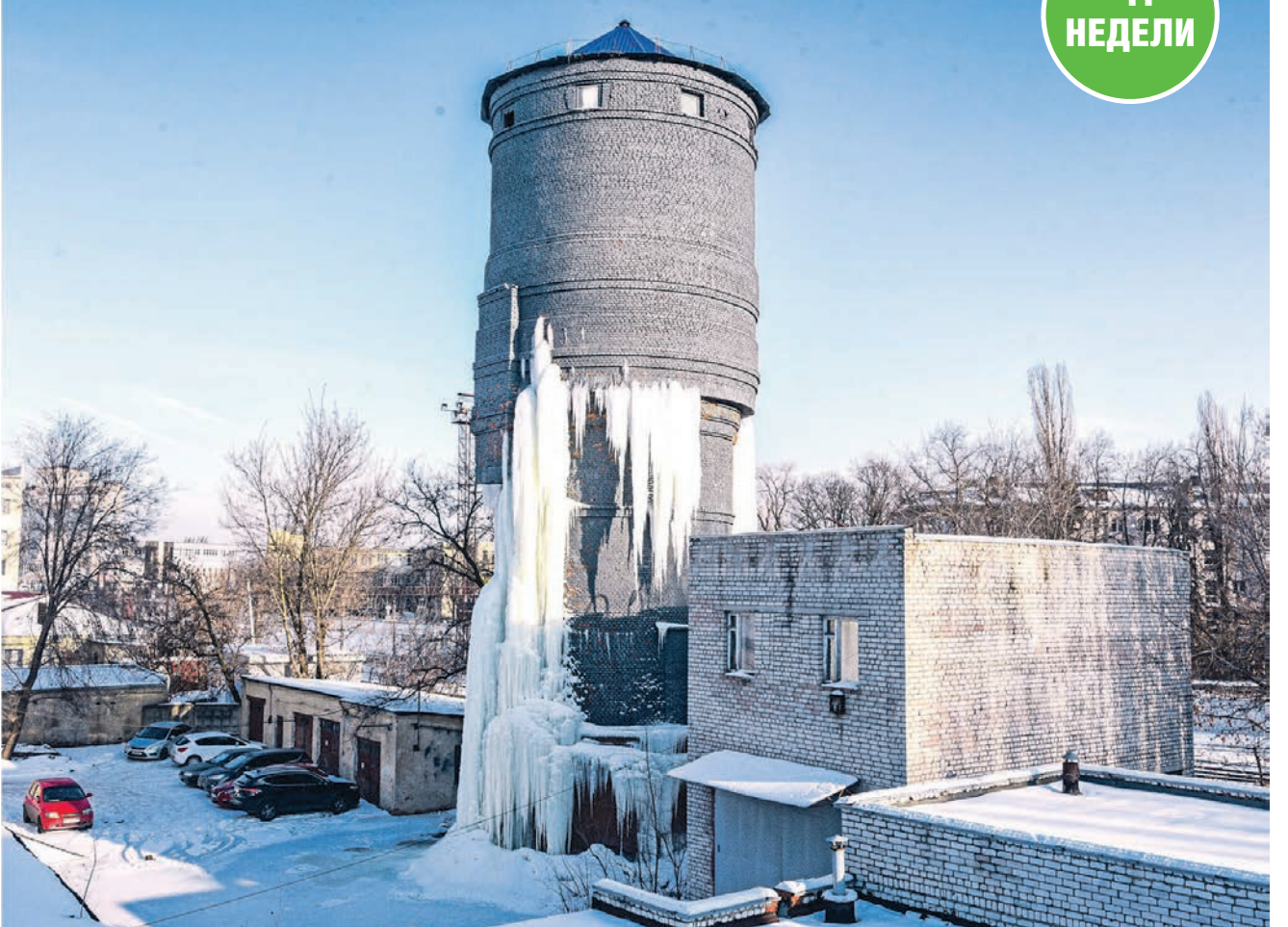
Из-за морозов в конце февраля водонапорная башня приобрела почти сказочный вид
