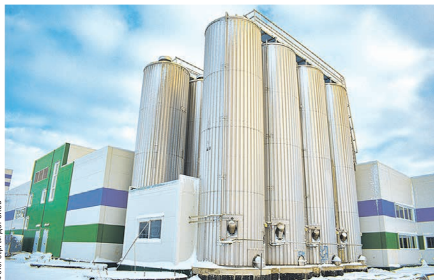
В январе 2022 года откроется новая площадка Бобровского сырзавода — сейчас здесь устанавливают современное оборудование, привезённое из Германии
