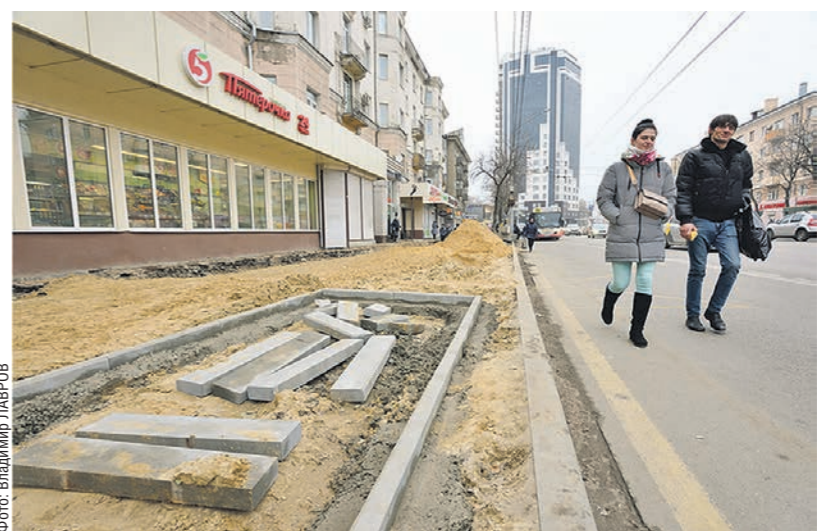
По словам экспертов, во время ремонта тротуаров необходимо организовывать обходные коридоры
