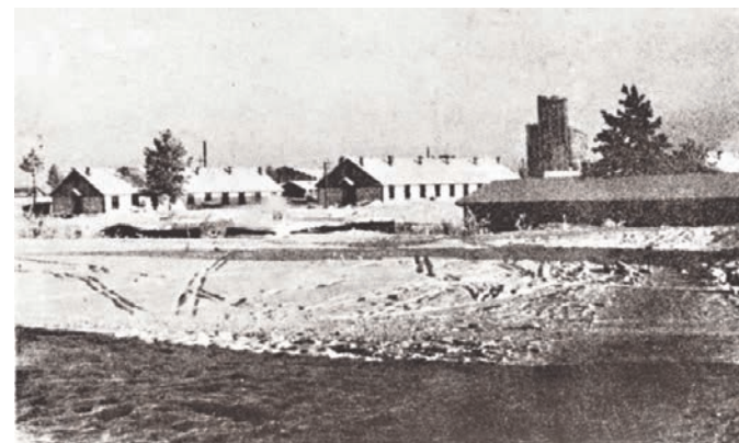
Здания зернохранилищ, в которых начинал свою работу коллектив ОКБ в годы Великой Отечественной войны
