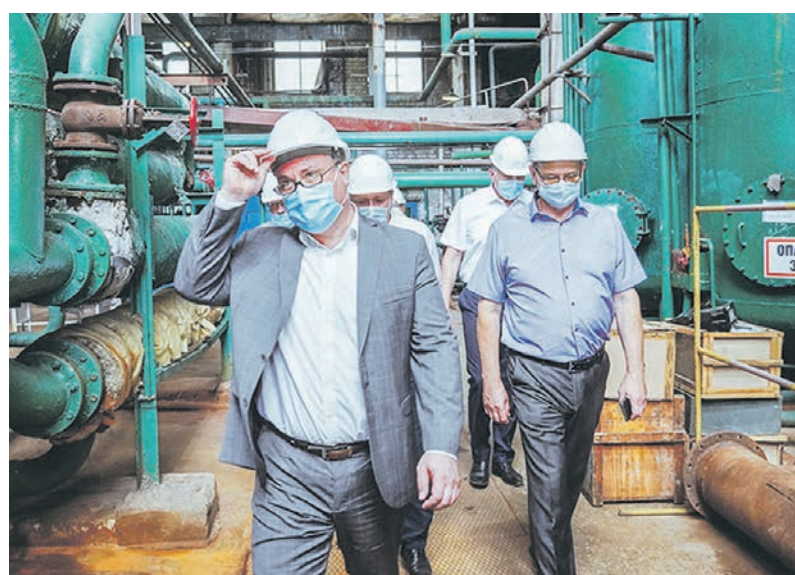
По словам Вадима Кстенина, реконструкция и замена тепловых сетей Воронежа идёт хорошими темпами
